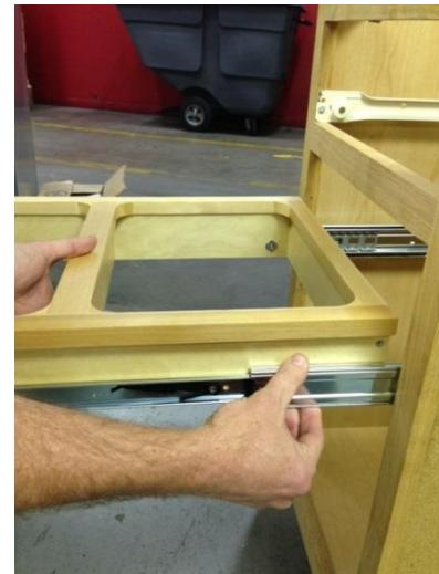
Paso 6 Empuje con cuidado el marco de montaje superior hacia el interior del gabinete. Habrá alguna resistencia a restaurar el mecanismo de cierre suave. Abra y cierre completamente el marco varias veces para asegurarse de que esté funcionando correctamente.
