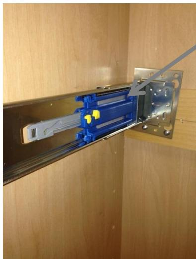
Le mécanisme en plastique bleu doit maintenant être rétracté vers l'arrière de la glissière. Veillez à faire ceci sur les deux glissières.
